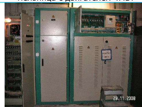
Совместная работа с устройством плавного пуска ВНИИР
